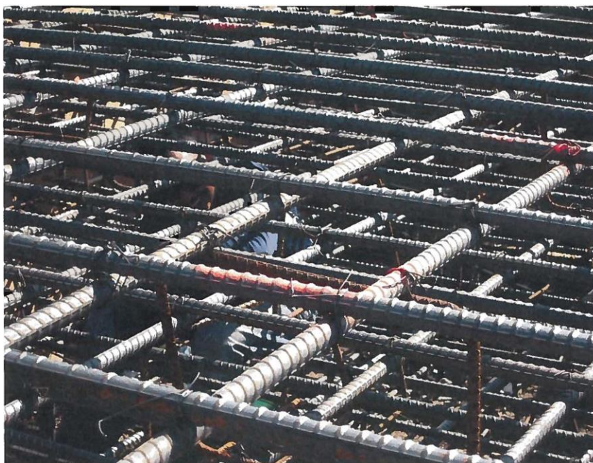
Figure N.15: Rebar tied together with wire.
