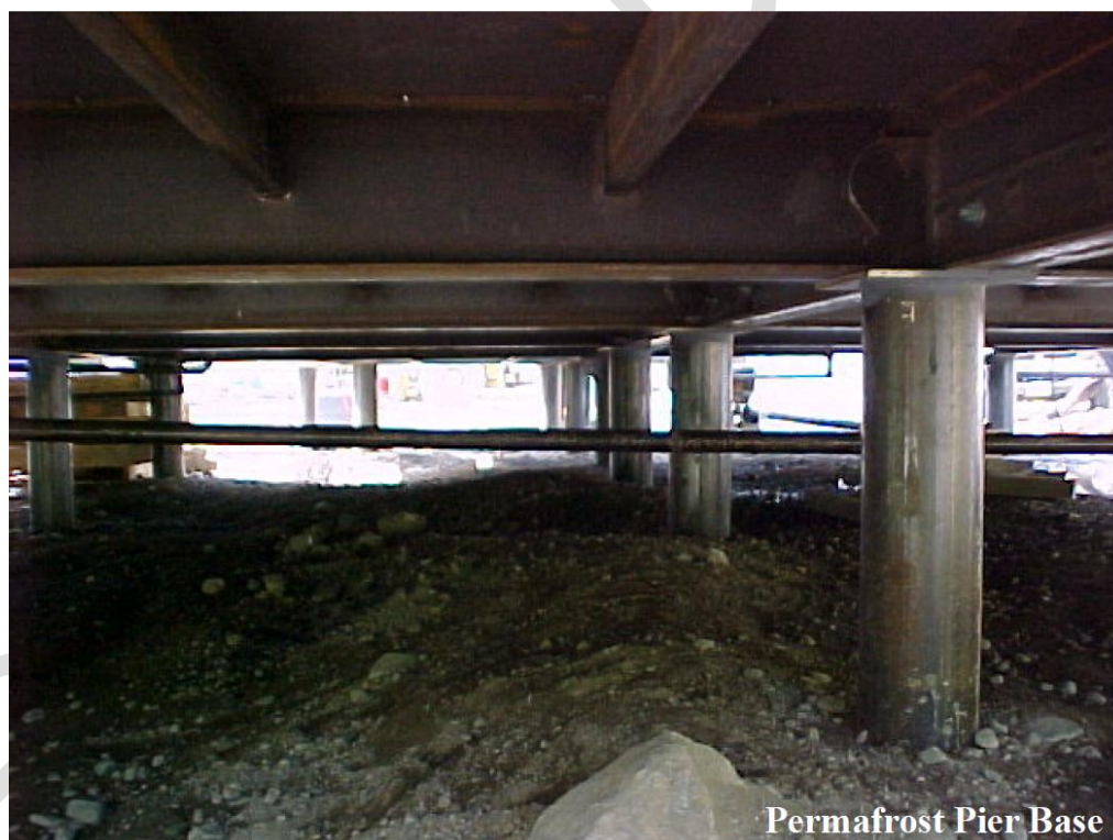
Figure N.18: Skid mounted on driven piles.
